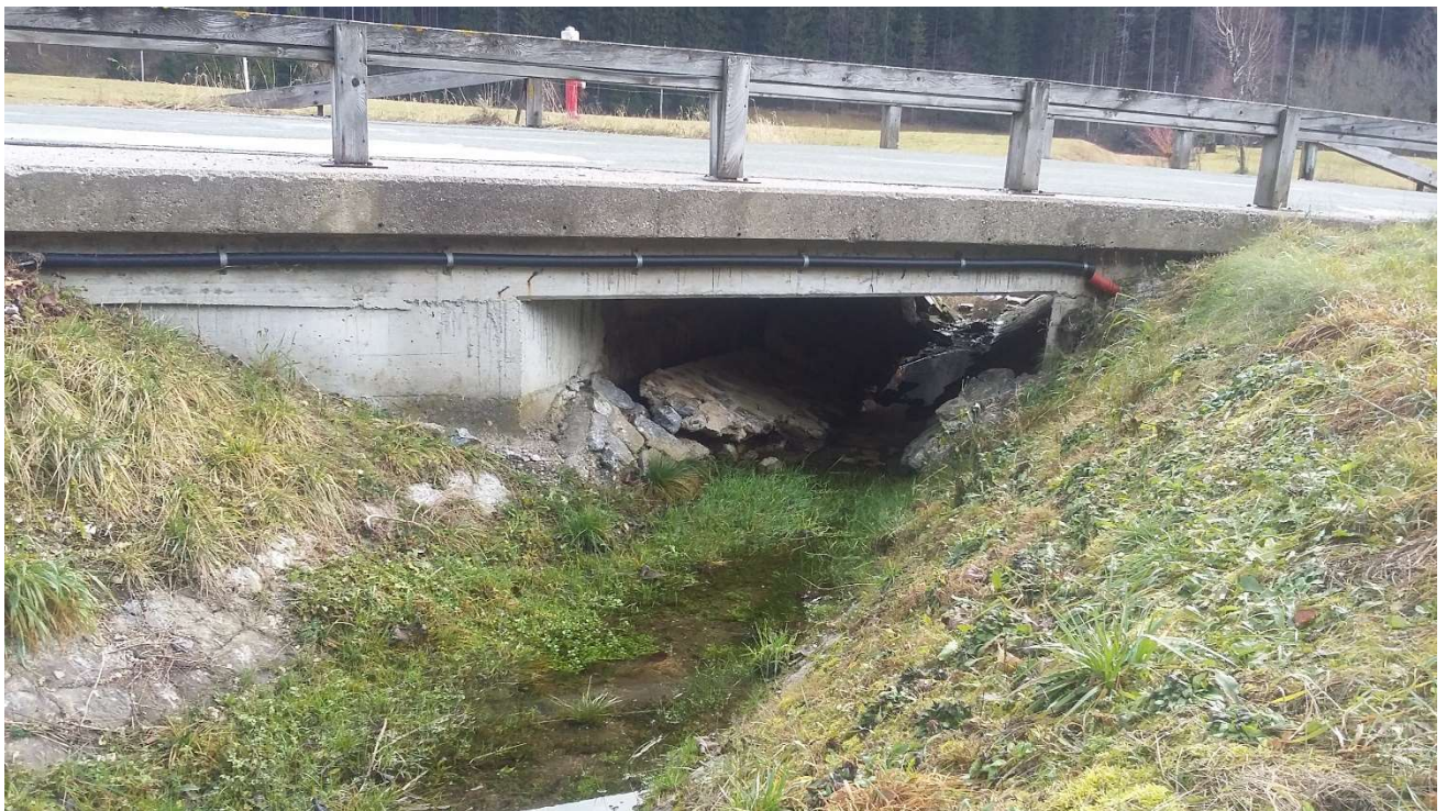
Slika 3: prepust v km 5+817
