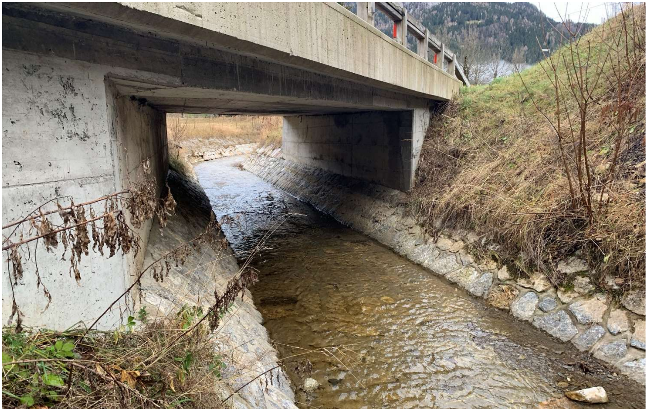
Slika 2: prepust v km 5+258 čez Ankov graben
