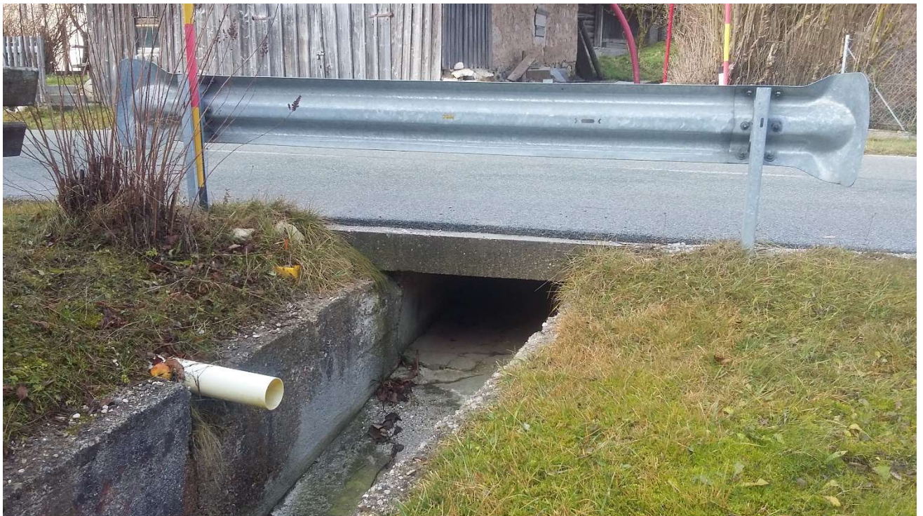
Slika 7: prepust v km 6+196
