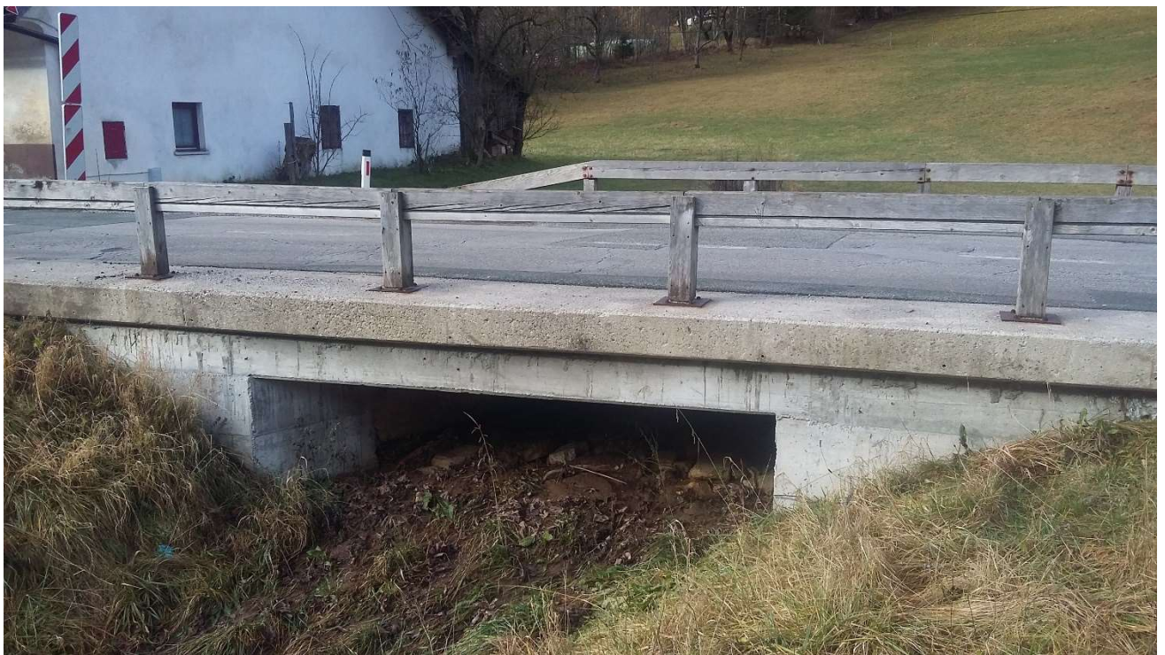
Slika 5: prepust v km 6+149
