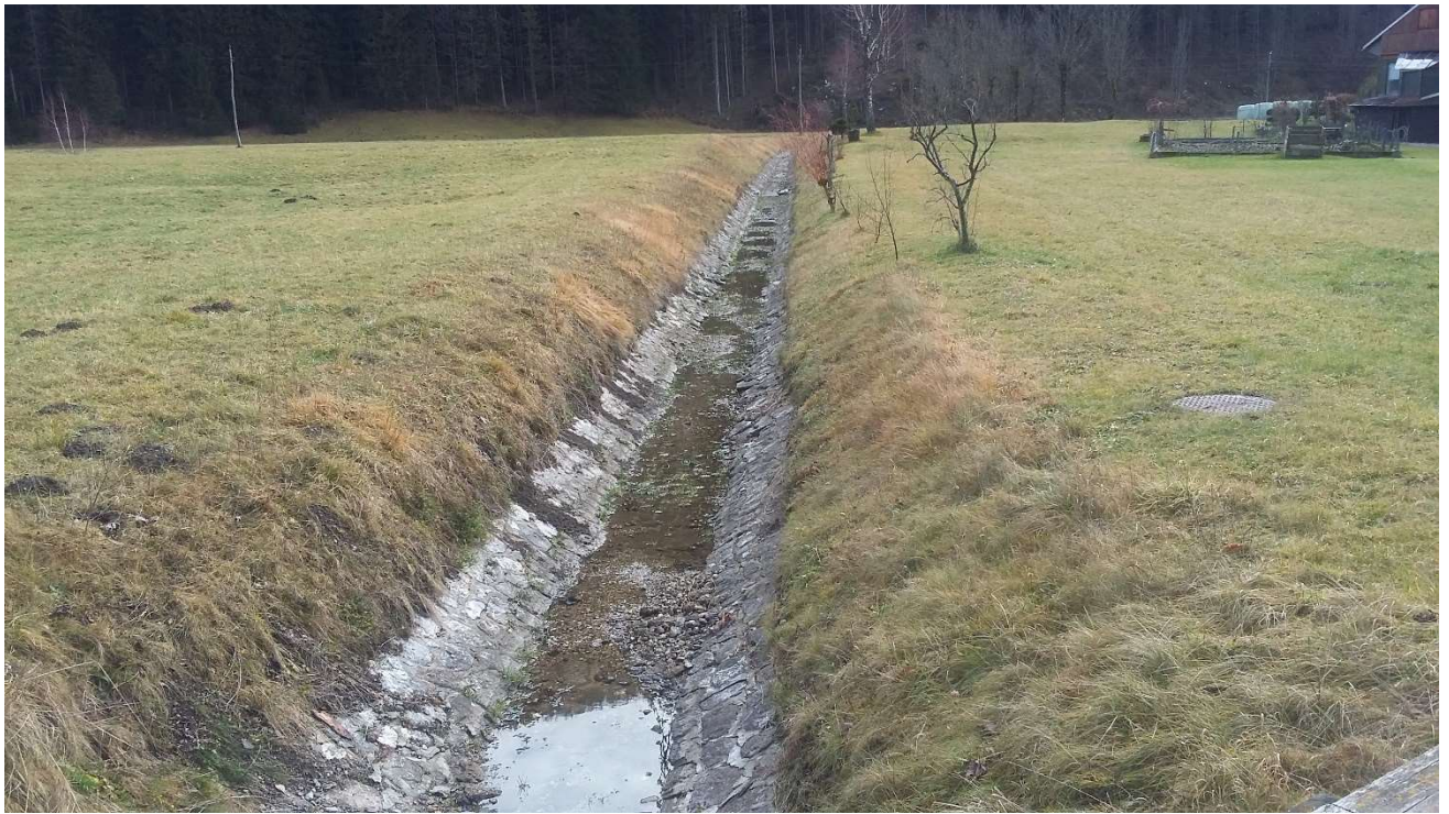
Slika 4: struga dolvodno od prepusta v km 5+817
