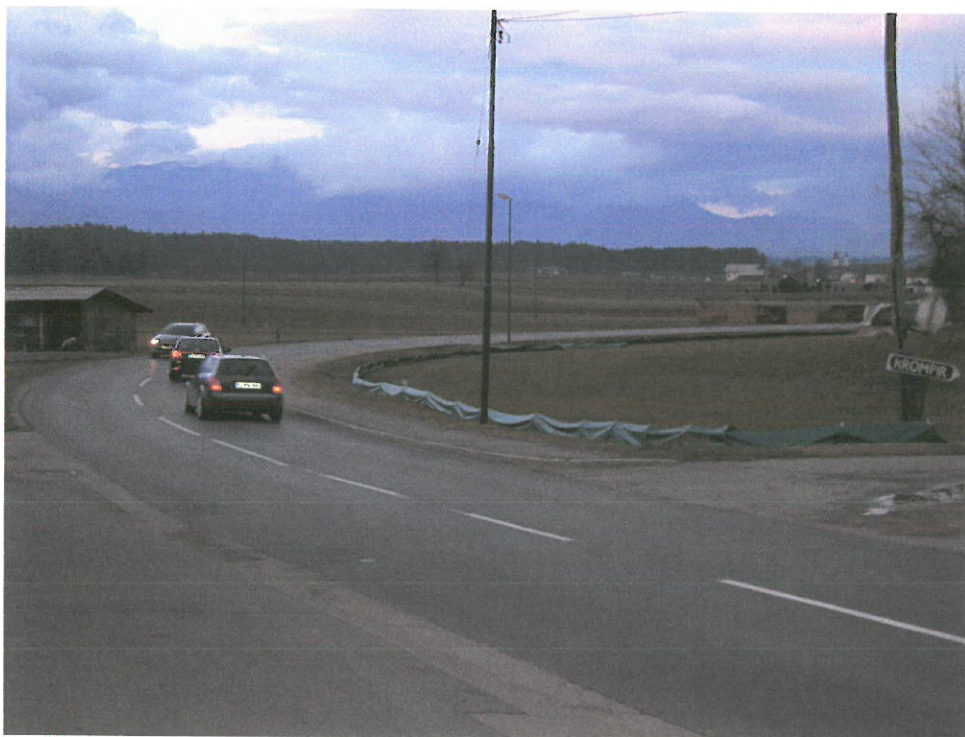
Slika 2: Regionalna cesta R2/413 1079 Zbilje – Vodice z začasno varovalno ograjo postavljena v času akcije "Pomagajmo žabicam" 2011
