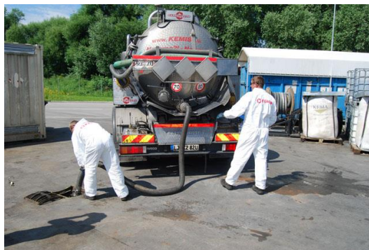
6. Iz kanala se izčrpa tekočino v cisterno
