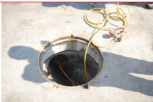
5. Kanal odtočnega jaška se zapre z balonom, s katerim se v jašku zapolni odtočna cev in prepreči iztok odpadne tekočine naprej v kanalizacijo.
