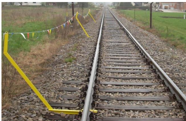
Slika 37: Način namestitve signalne vrvice na kotni profil, ki se pritrdi na nogo tirnice
