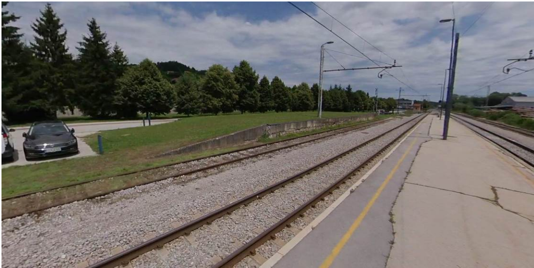
Slika št. 4: Obstoječa nakladala klančina na levi strani postaje
