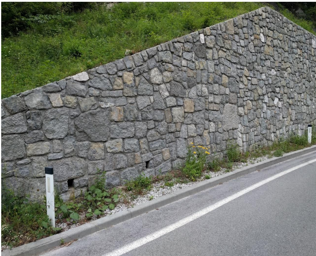
Slika 4: Željen izgled opornih konstrukcij
