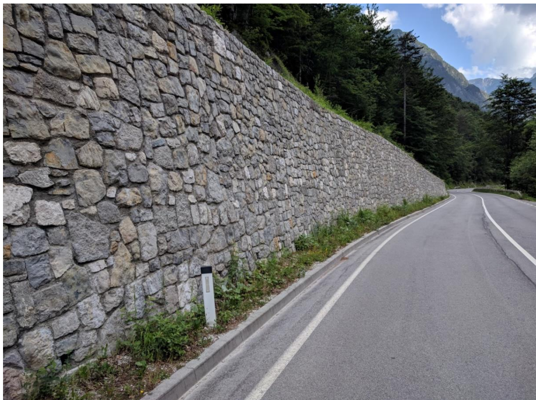
Slika 3: Željen izgled opornih konstrukcij
