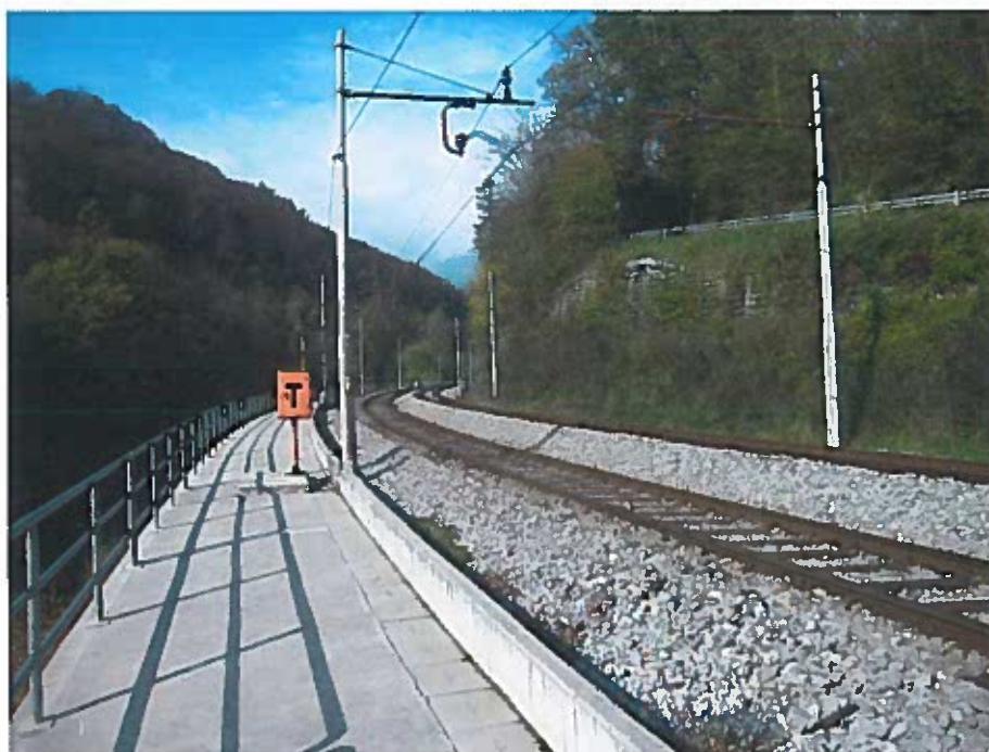
Kaštni zid na strmem pobočju nad progo in pod cesto
